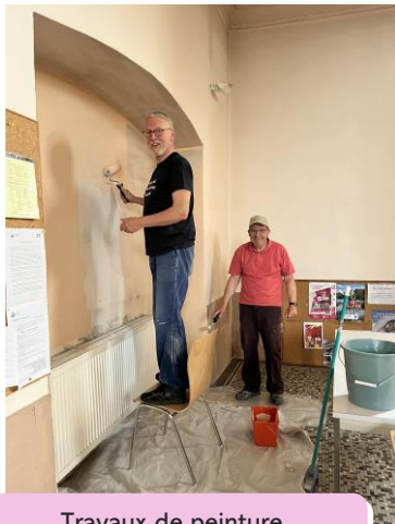
Travaux de peinture à l'intérieur de l'Église
